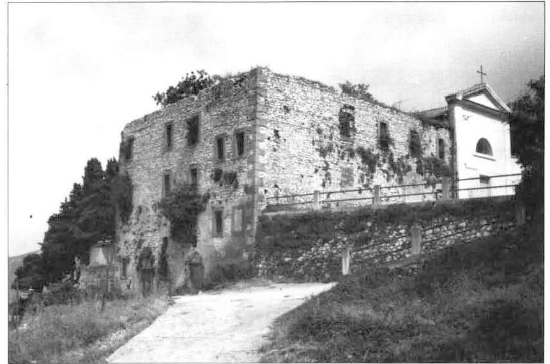
Convento dei Padri della Dottrina cristiana e Chiesa di S. Rocco, esterno.
